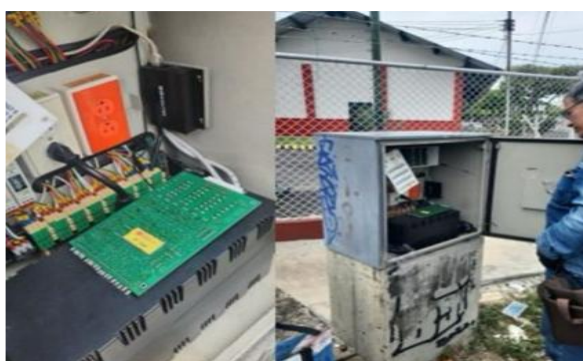
Instalación de tarjeta de potencia nueva
