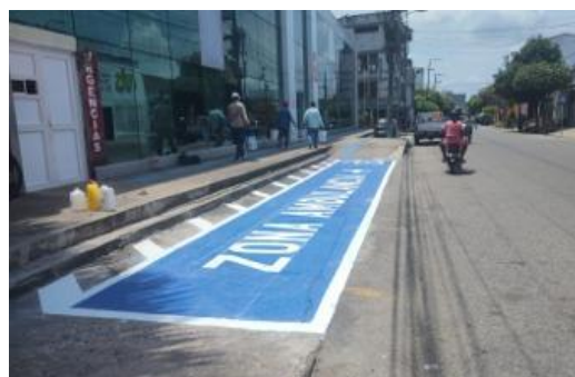
Señalización Calle 48 entre Cra. 21-22
