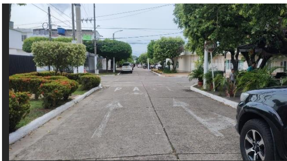
Señalización Horizontal Calle 44 CRA 26 El Recreo - Antes
