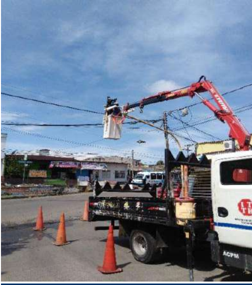
Reparación Calle 52 A carrera 36D
