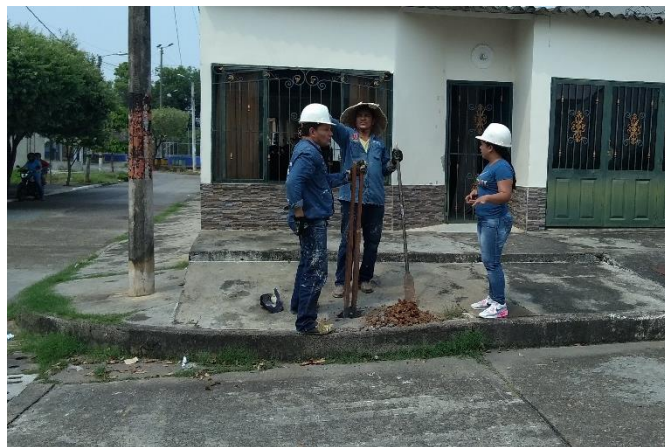
Barrio nuevo horizonte, señal de PARE.
